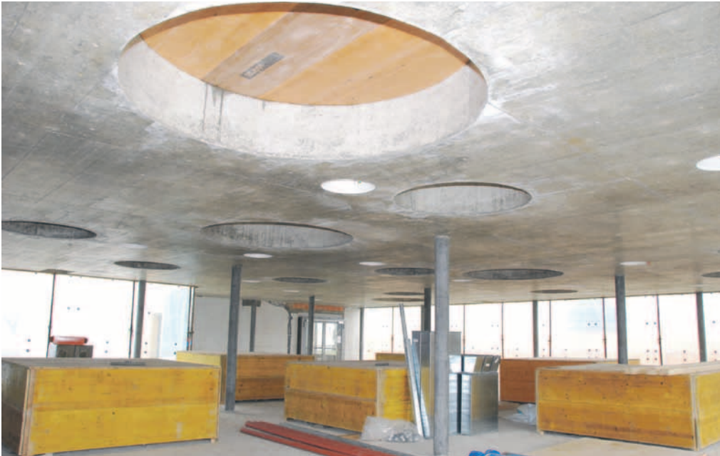
Die «neue Mitte», die grosszügige Pausenhalle, nimmt Formen an: Die heute noch abgedeckten runden Deckenlöcher werden verglast und bringen künftig zusätzliches Tageslicht in die Halle.
