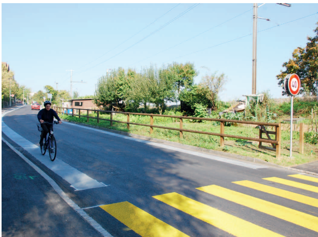
Die sanierte Kirchstrasse im Bereich Gurtenbühl. Die Sicherheit für Fussgänger und Velofahrer konnte trotz engen Platzverhältnissen verbessert werden.
