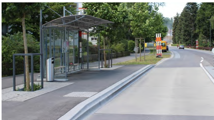
Abb. 1: Hindernisfrei gestaltete Haltestelle „Morillon“ der Linie 29
