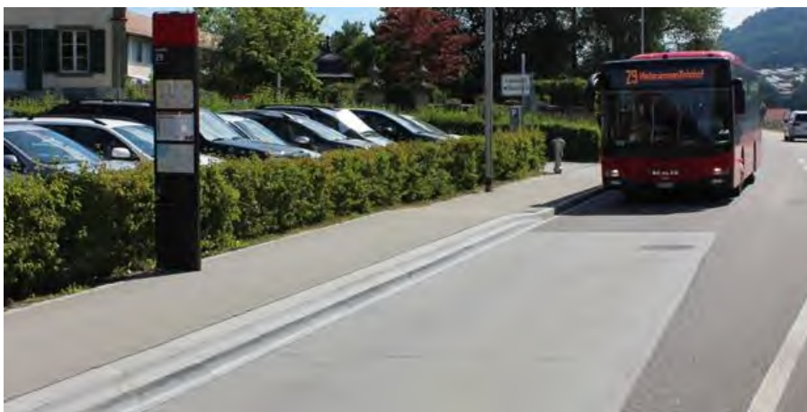
Abb. 2: Aus der Netzbetrachtung macht es Sinn, auch eine weniger frequentierte Haltestelle hindernisfrei umzubauen: Haltestelle „Landorf“ der Linie 29.
