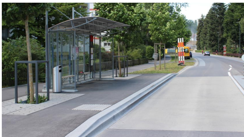
Abb. 1: Hindernisfrei gestaltete Haltestelle „Morillon“ der Linie 29
