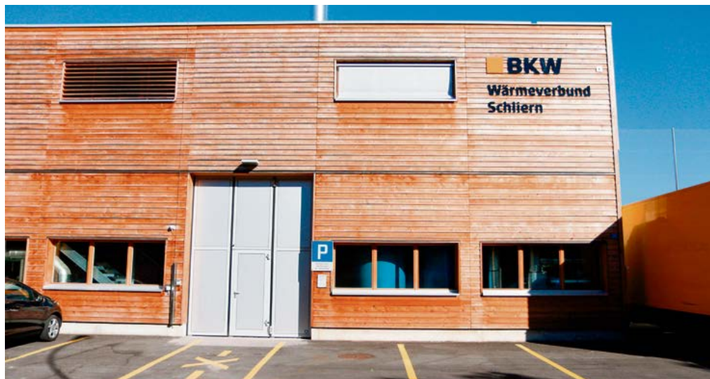
Die Heizzentrale in Schliern.
