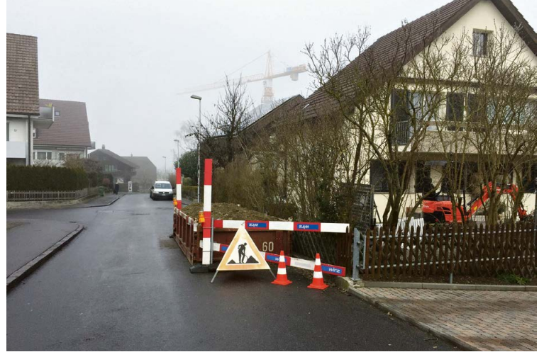
So soll es sein: Schuttmulde auf öffentlicher Strasse, abgescrankt und bei Nacht beleuchtet.
