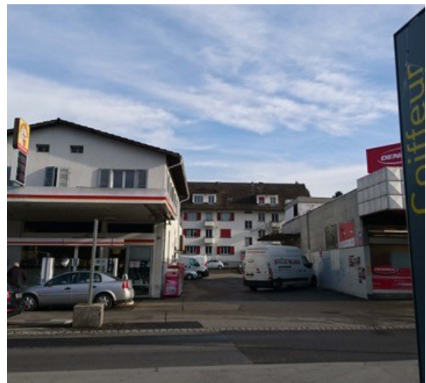
Abb. 6: Bestandsgebäude / Zufahrt Parkplatz
