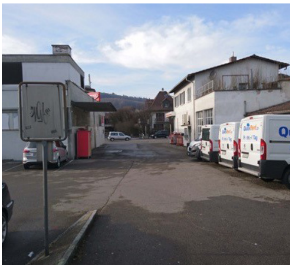
Abb. 7: Bestandsgebäude / Situation Hofseite
