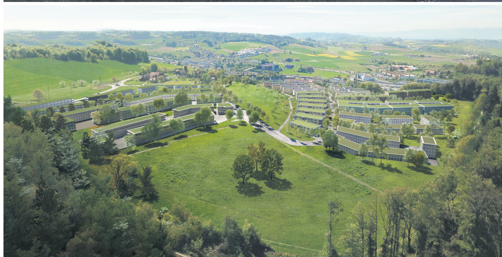
Bild oben: Einige Wohnungen in der Überbauung Papillon Ried sind bereits bewohnt, während andere noch im Bau sind oder vor dem Baustart stehen. | Bild unten: So wird die Überbauung, deren Anordnung einem Schmetterling gleicht, dereinst aussehen. | Fotos: zvg
