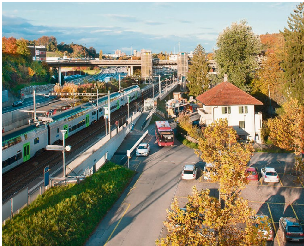
Blick auf das Bahnhof-Areal Niederwangen, wie es heute ist.
