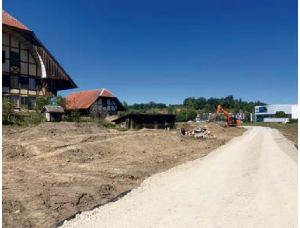
Im Unteren Juch in Niederwangen wird gebaut. | Foto: Emch+Berger AG
