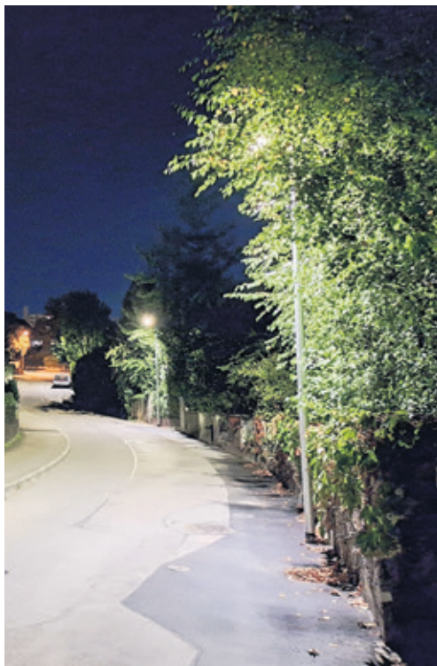
LED reduziert Lichtstreuung und lässt gezielt den Strassenraum erhellen. | Foto: Gemeinde Köniz
