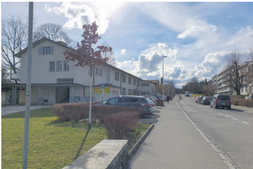
Im Buchsee-Quartier wird ab Mitte April 2023 ein Wärmeverbund gebaut. | Foto: zvg
