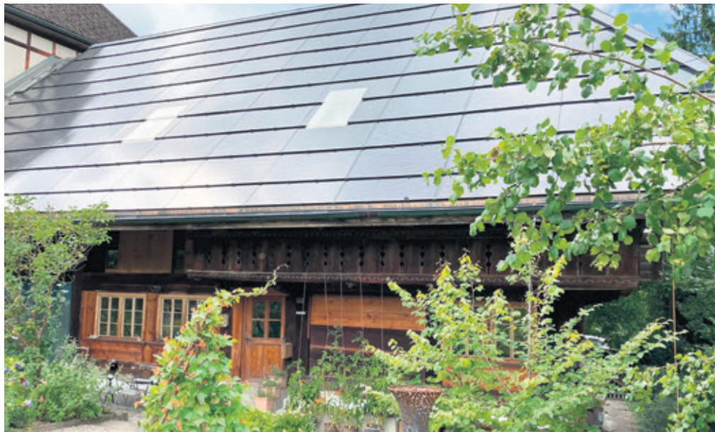
Das Zingghaus in Köniz: Die Solarenergie kann auch auf denkmalgeschützten Gebäuden genutzt werden, so wie hier mit dieser dachintegrierten Photovoltaikanlage.
