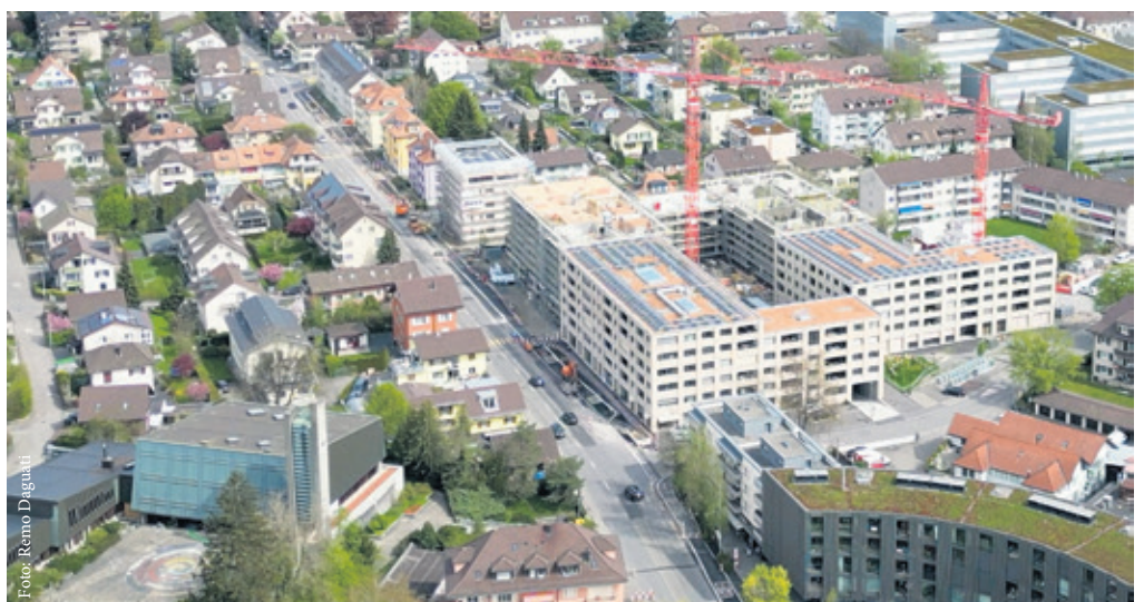
Die Neuüberbauung flo&fleur im Bau, 2023. Rechts im Hintergrund die Vorgängergebäude aus den 60er-Jahren. In der dritten Bauetappe entsteht hier aktuell das letzte neue Gebäudeensemble.
