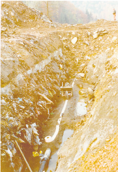
Nachträglicher Einbau Entgasungsleitungen im Jahr 1990. | Foto: zvg
