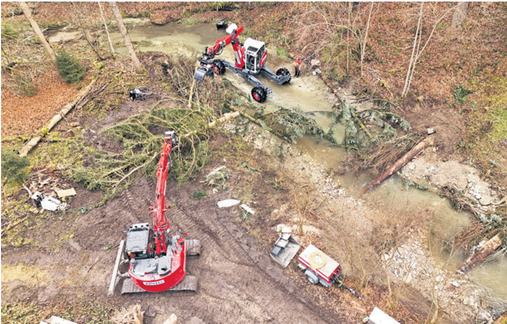
Totholz in den Scherlibach verlegen: Die IUB Engineering AG sorgte im Februar für den Uferschutz.
