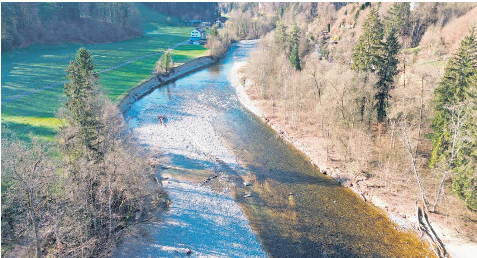
Die Sense schwemmte bei Hochwasser das Ufer mit dem Wanderweg im Oberlauf fort (oben links). Darum ist der Wanderweg nach Heitibüffel länger gesperrt.
