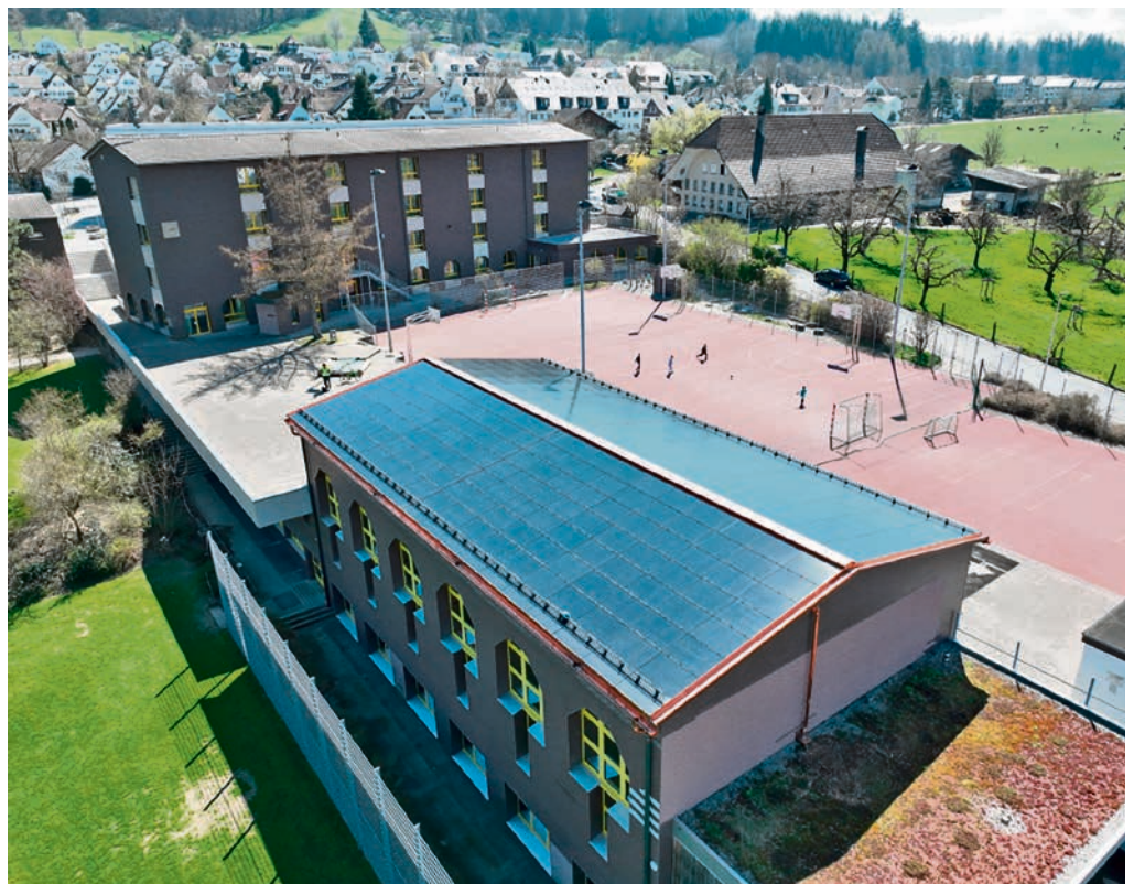
Komplette Dachsanierung nach Turnhallenbrand im Spiegel: Eine Gelegenheit für die Photovoltaik.
