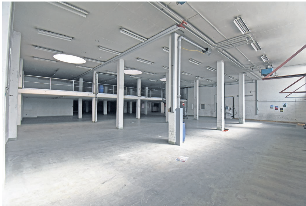
Viel Raum und noch roh. Im September wird diese Halle an der Sägestrasse 65 zum Erlebnisraum.
