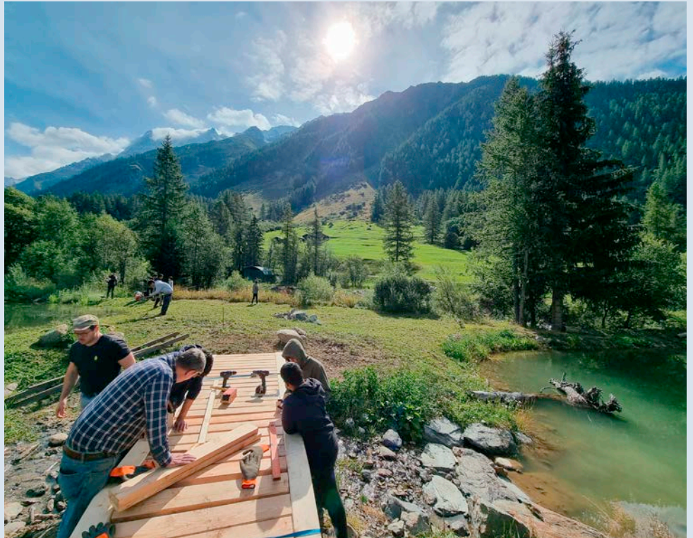
Die Schüler beim Brückenbau und Errichten einer neuen Grillstelle.
