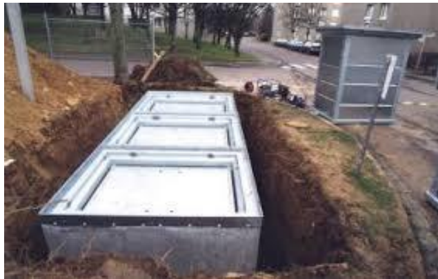
Skizze 1 Unterflurcontainer mit Betonwanne
