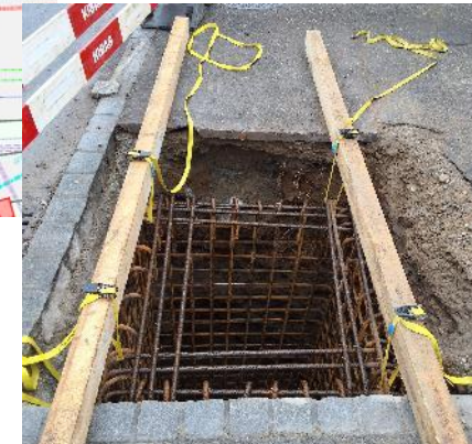
Fundament Fahrleitungsmasten
