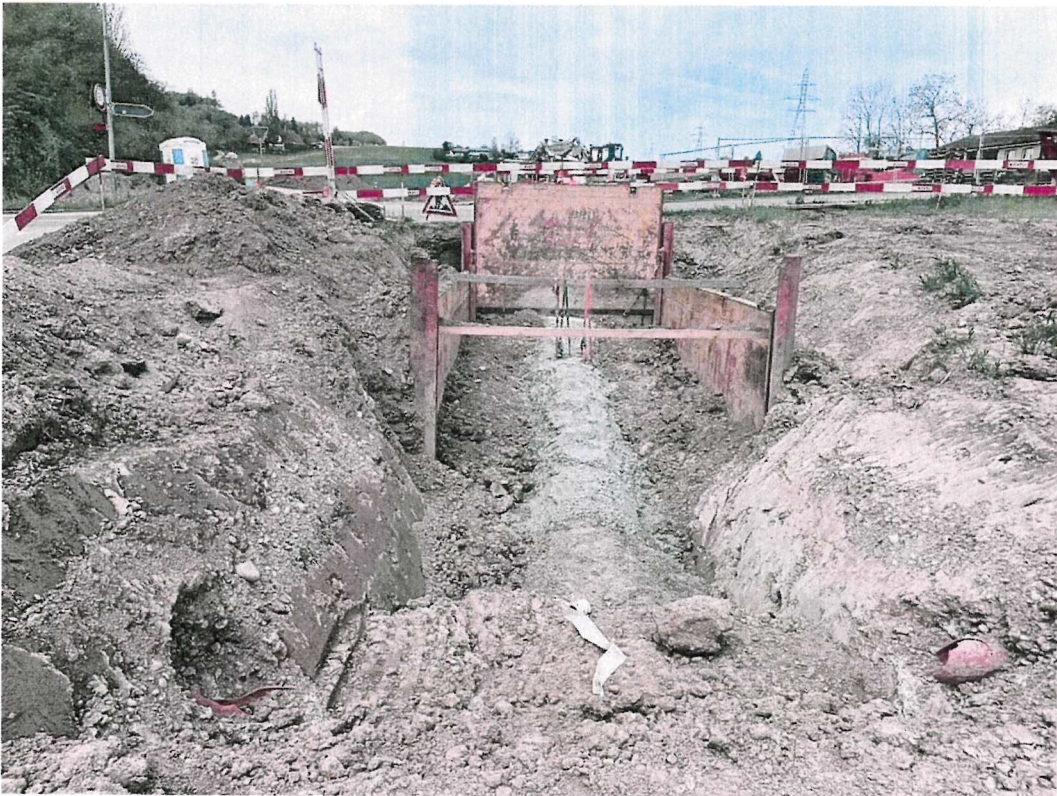
Rohre mit Beton geschützt
