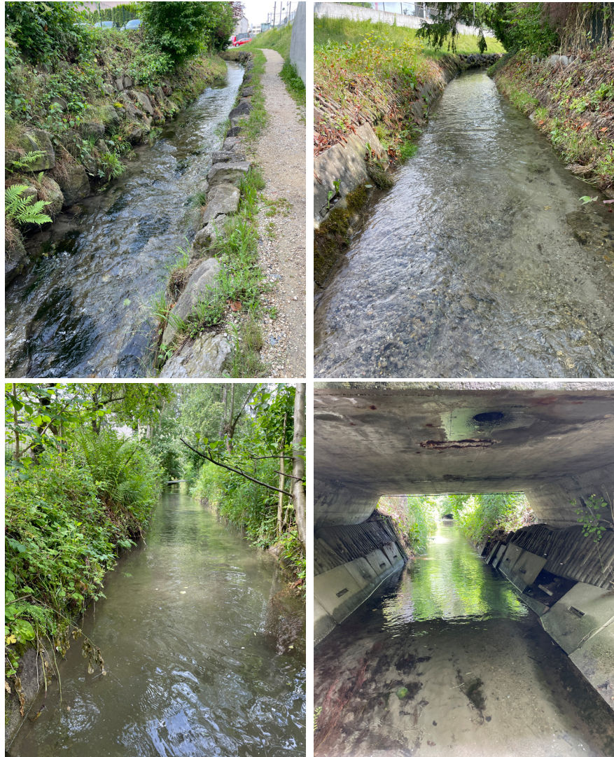
Abb. 8: Fotos des Stadtbachs im Gewässerabschnitt, oben: Abschnitt Wangenbrüggli bis Durchlass SBB, unten: südliche Brücke bis Wangebrüggli. Quelle: ARNAL AG.
