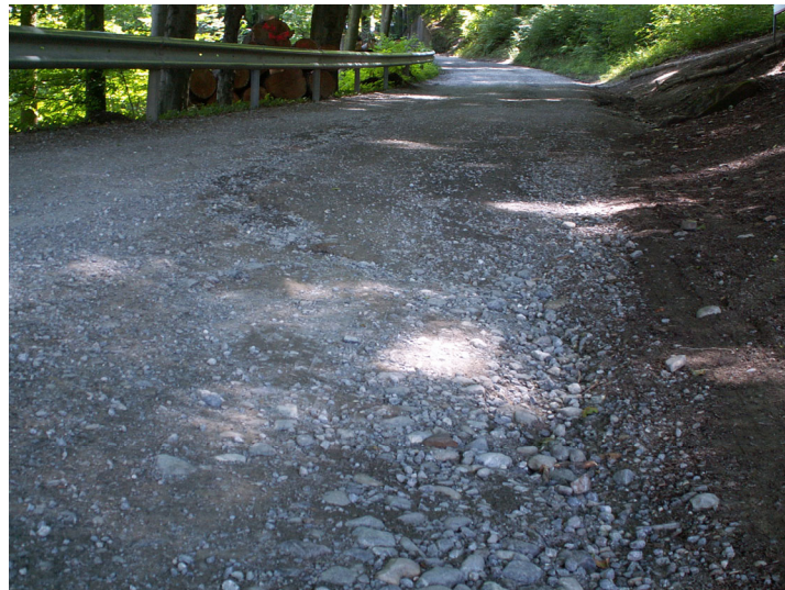
Aufwändige und teure Unterhaltsarbeiten haben noch kein Ende: Die Gurtendorfstrasse
