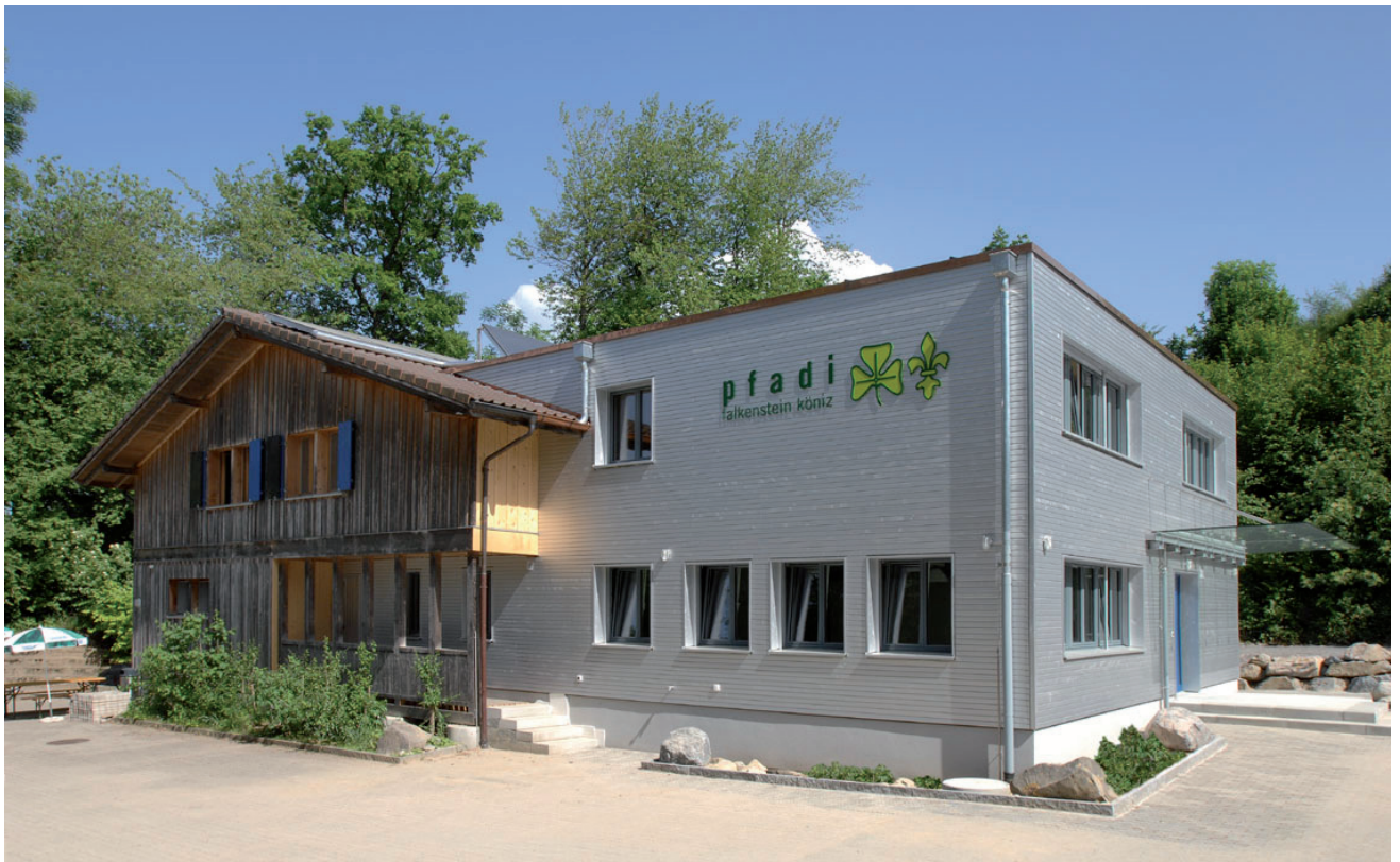
Das Büschiheim ist das erste MINERGIE-Pfadiheim der Schweiz. Die Photovoltaikanlage auf dem Dach haben die PfadfinderInnen selber installiert.
