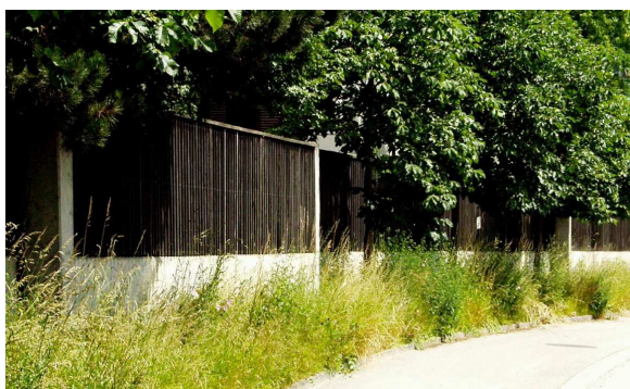
Abb. 3.2-1: Beispiel Lärmschutzwand dito Bruggbühlstrasse
