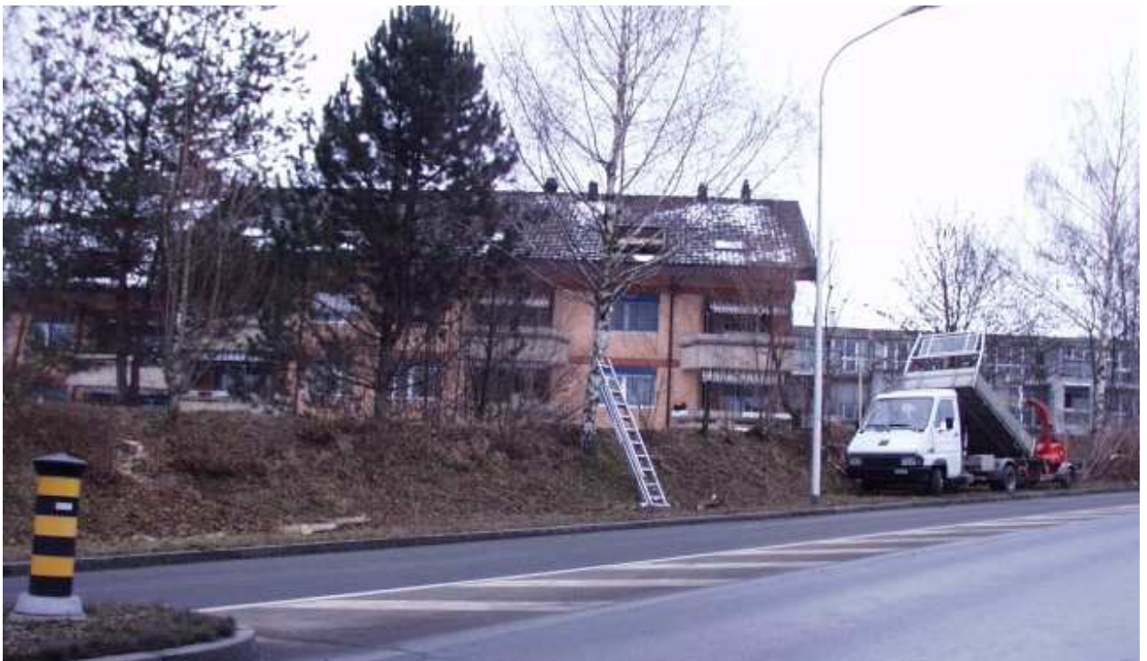
Standort neue Lärmschutzwand Brüggbühlstrasse
