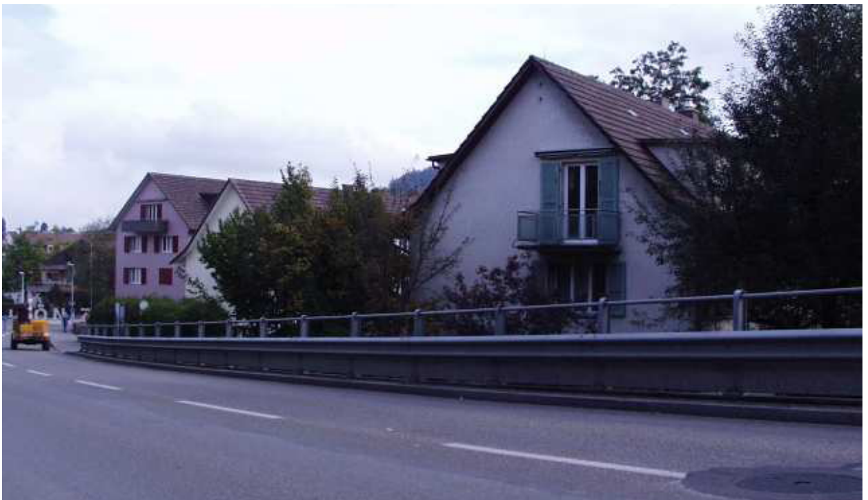
Standort neue Lärmschutzwand Weiermattweg
