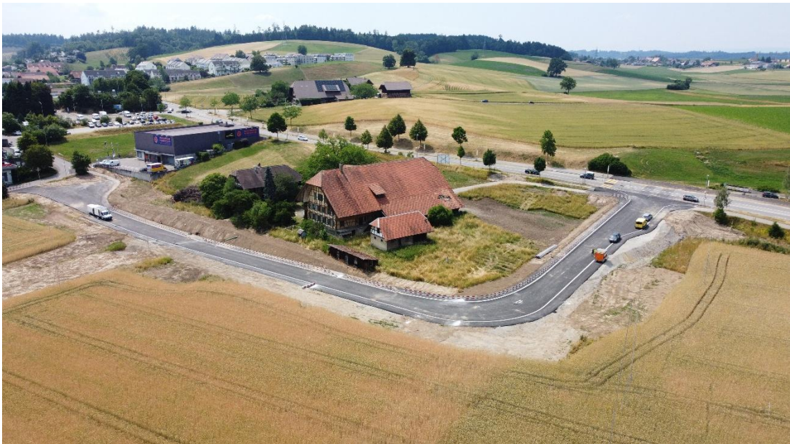
Untere Juchstrasse, Niederwangen
