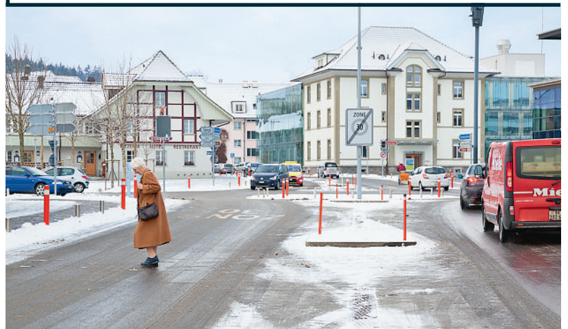
Das komplett neu gestaltete Zentrum von Köniz. Früher bestand es aus einer Durchgangsstrasse mit 18 000 Autos pro Tag. Heute gilt Tempo 30, und eine Koexistenzzone sorgt für Gleichberechtigung der Verkehrsteilnehmer.
