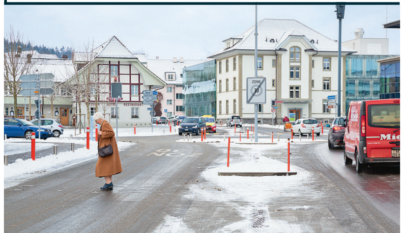
Das komplett neu gestaltete Zentrum von Köniz. Früher bestand es aus einer Durchgangsstrasse mit 18 000 Autos pro Tag. Heute gilt Tempo 30, und eine Koexistenzzone sorgt für Gleichberechtigung der Verkehrsteilnehmer.
