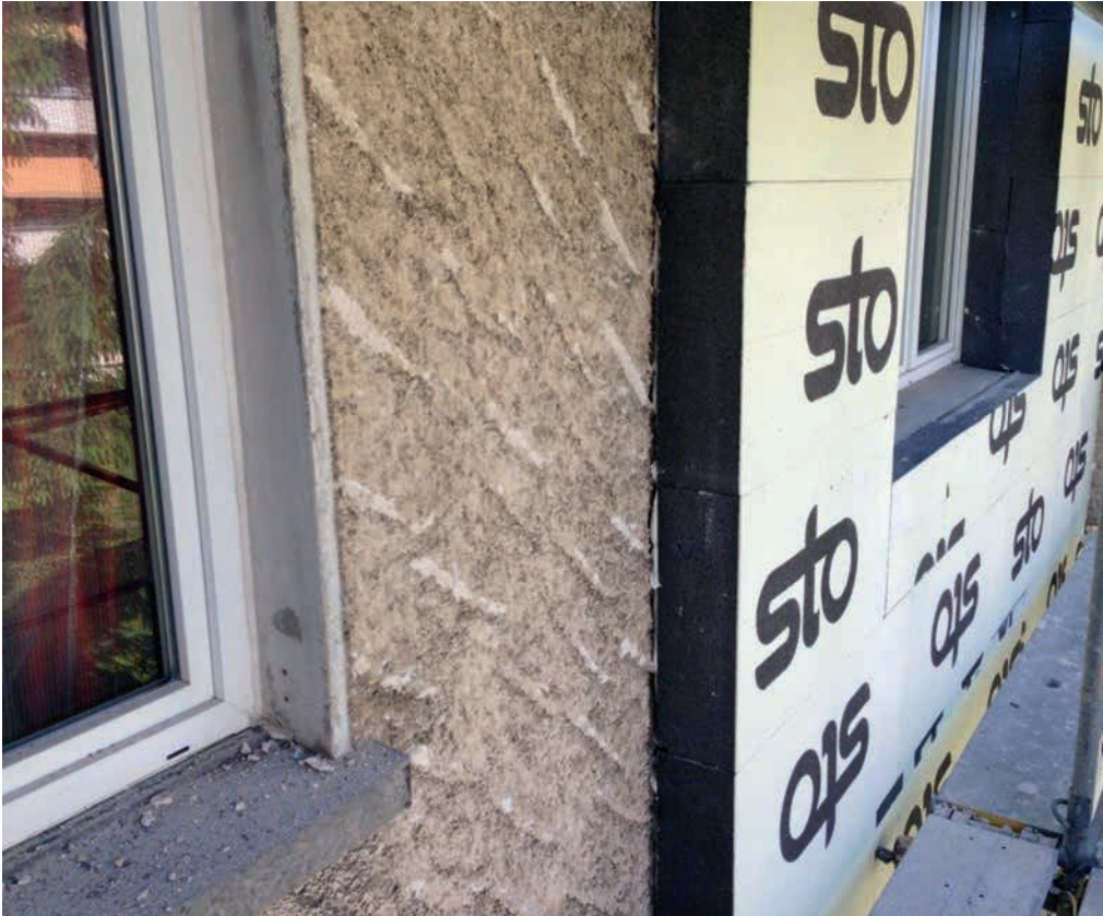
Bei der Sanierung von Gebäuden ist die Isolation von grosser Bedeutung. Wird eine neue Heizung angeschafft, sollte idealerweise auch der Einsatz von erneuerbaren Energieträgern geprüft werden.
