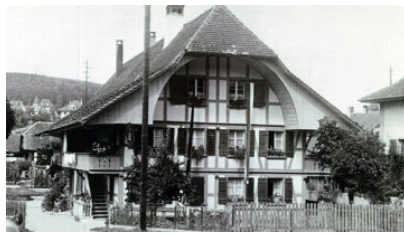
Ruedelihaus, Schwarzenburgstrasse 292, 1958, vor Abbruch
