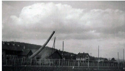
Liebefeld, Sprengung Hochkamin Sägemehli, Könizstrasse
